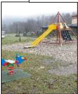
Rekonstrukce dětského hřiště v Hoštejně
