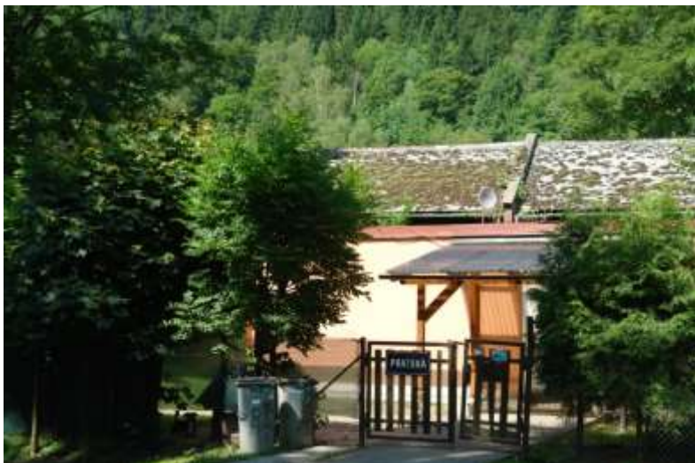
Obrázek č. 12: Negativa v Hanušovicích - ulice Pražská
