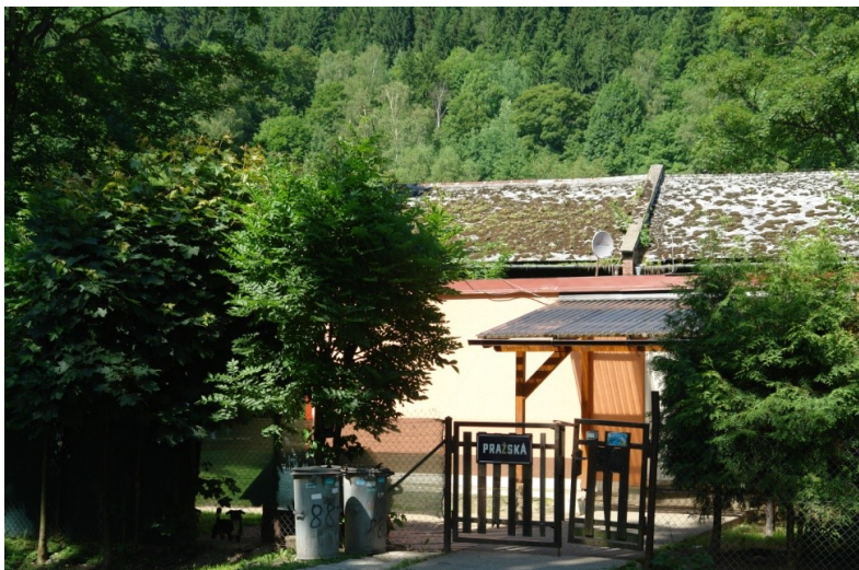
Obrázek č. 12: Negativa v Hanušovicích - ulice Pražská
